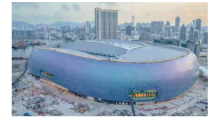
啟德發展計劃 —前北面停機坪第5b期基礎設施工程
