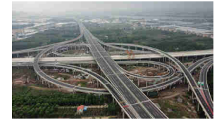
中山市西環高速公路工程為中山市的重點工程之一。
